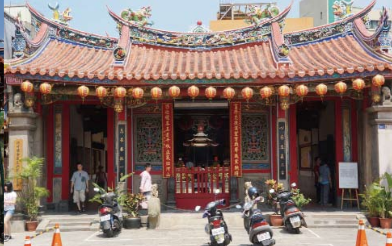
廟頂為三川脊式：將屋脊中央一段抬高，兩邊較低，使屋脊分為三段，並增高「垂脊」，五丁造型更有層次變化。
